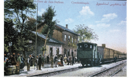
Yeşilköy Tren İstasyonu
