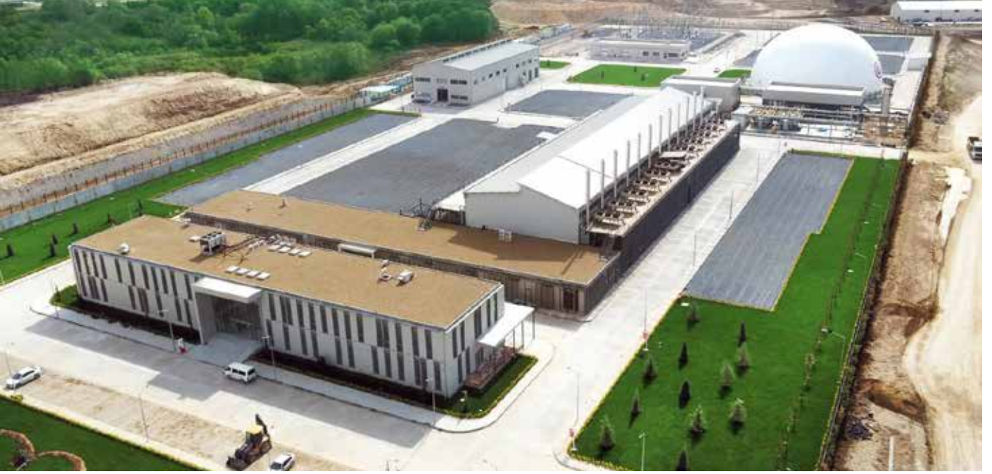
İstanbul'daki atıktan enerjiye dönüşüm tesisi
